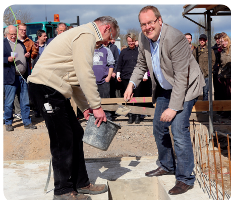
ITB Geschäftsführer Frank Quinders (re.) legt den Grundstein des neuen Gebäudes in Kamp-Lintfort
